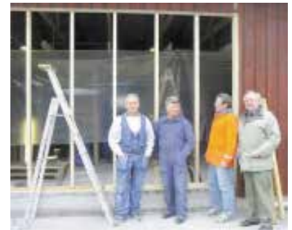
Porten är såld och hålet skall täppas till. Reglarna är på plats, arbetslaget tar en paus tillsammans med Bengt.
