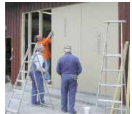
Byggplattor skruvas på reglarna.
