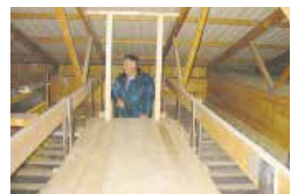
Mats inspekterar vindsutrymmet.
