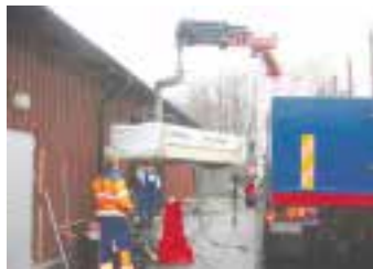
Leverans av trävirke till taket.
